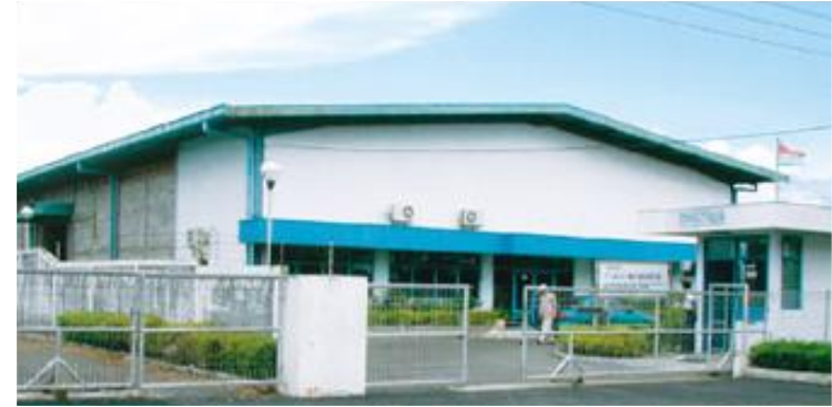
【PT MIYAZAWA INDONESIA外観】
