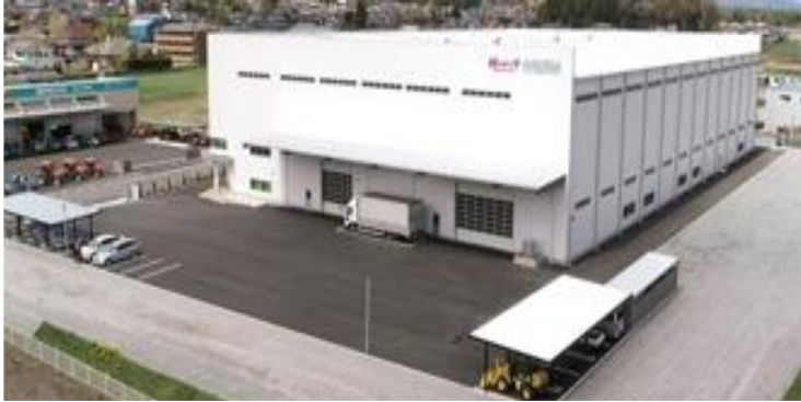
【伊那工場外観】
