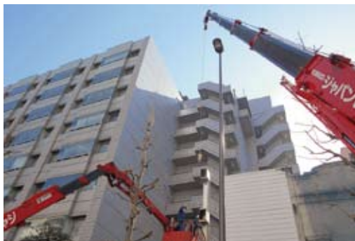
AT-195 (19.5m)・GR-120 (12t) 看板取付作業
