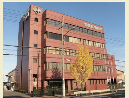
▲本社新築移転(1981年)
