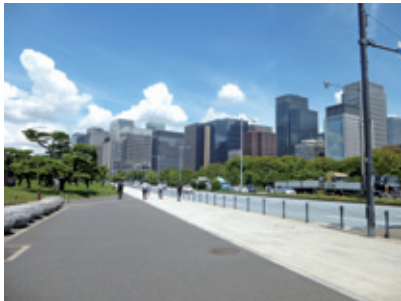
写真1 (皇居外苑から見た丸の内・大手町高層オフィスビル)
