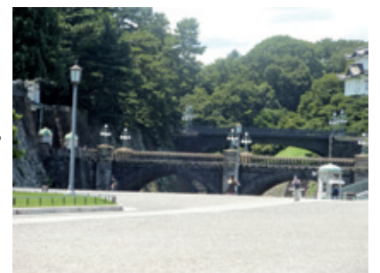
写真3 (正門鉄橋(二重橋))
