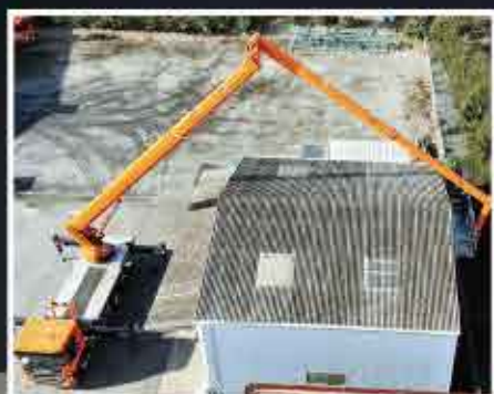
(回転バケットにより建物裏側の作業も可能)
