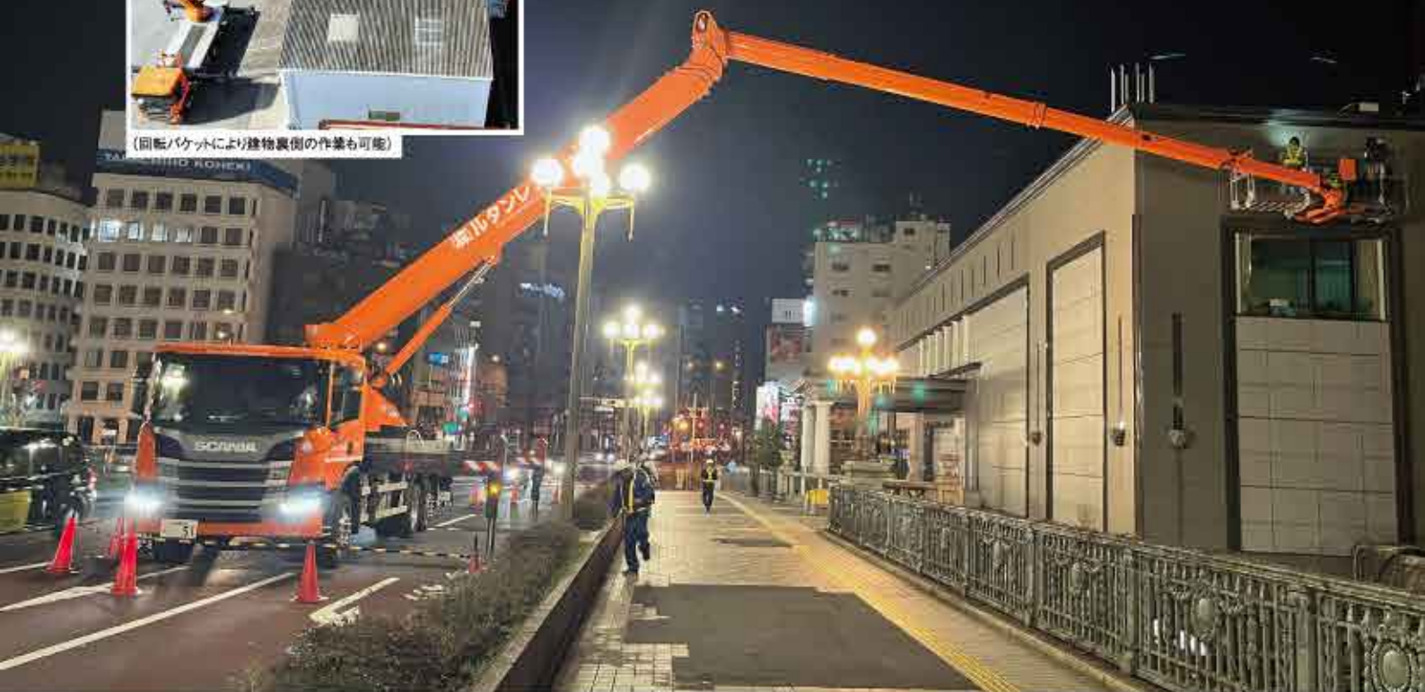
(導入後初現場!伸縮式バケットで作業効率UP)
