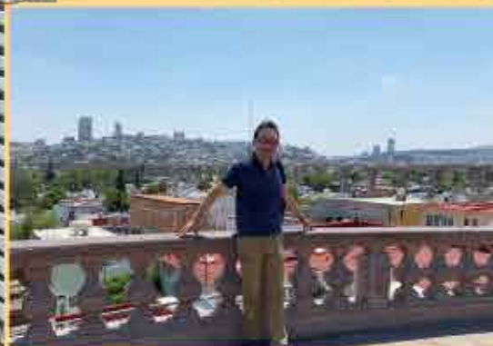
ケレタロ市内水道橋
